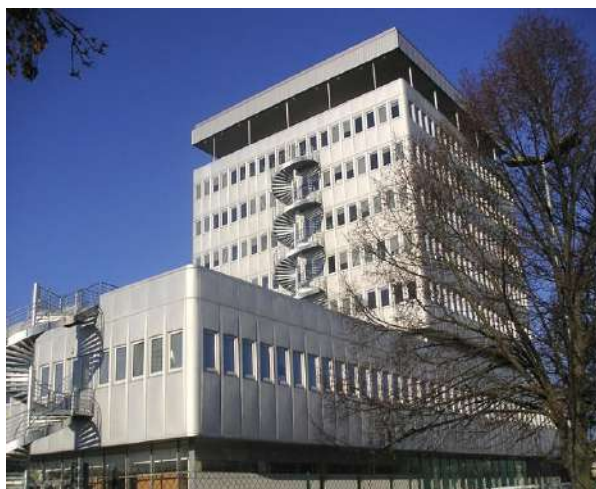
L'Institut de Formation des Cadres de Santé (IFCS), également rattaché au CPN, forme des professionnels de santé appelés à exercer des fonctions d'encadrement, de management et de coordination.
